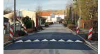
Plateau surélevé rue Castelnau
